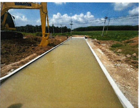
ภาพที่ 2-11 พื้นที่ล้างทำความสะอาดล้อรถบรรทุก
